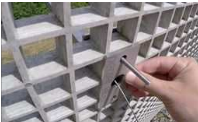
2 – 3. Câble passé dans le caillebotis puis dans l'orifice central de la plaque
