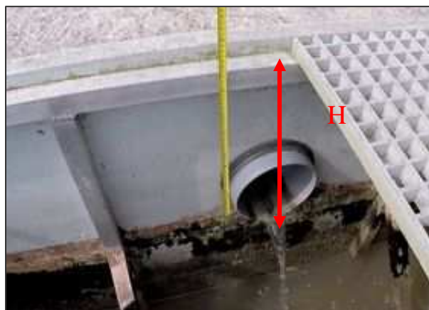
6. Mesurer la hauteur H entre le haut de la cuve et le bas du carottage d'entrée
