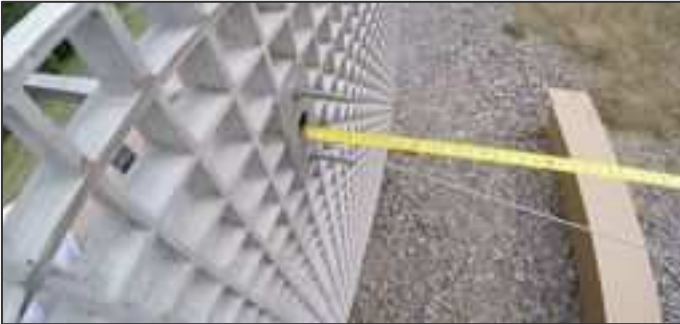
7. Mesure de la longueur du câble « H+20 cm »
