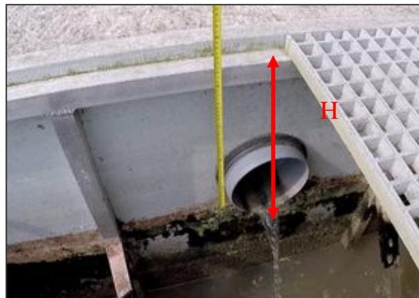
6. Höhe H zwischen Oberkante Behälter und Unterkante Zuflussrohr messen
