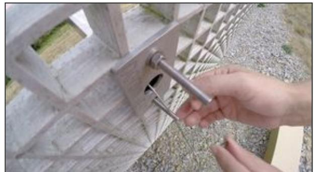
4 - 5. Bodenplatte unter Gitter anschrauben
