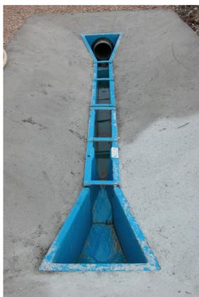
Photo 7 : Canal venturi maçonneré
