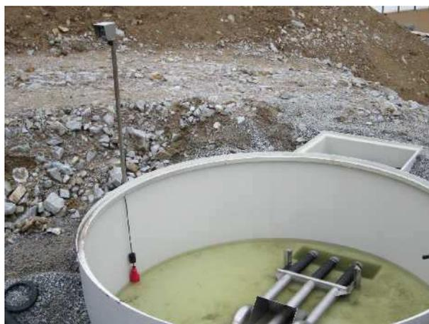
Photo 13 : Compteur numérique fixé sur la cuve avec poire de niveau
